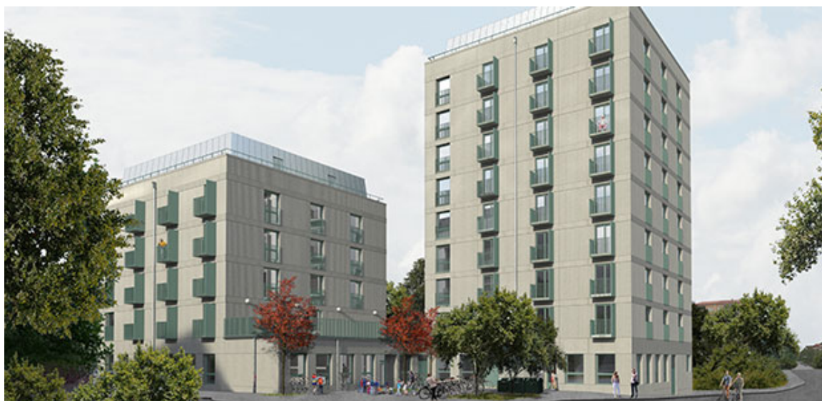
Bild som visar entrén från Årstavägen, Kv Gisslaren
